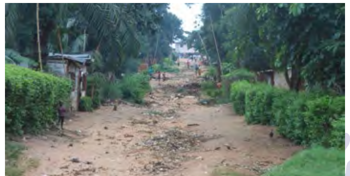
Esempio di strada disastrosa in centro città
