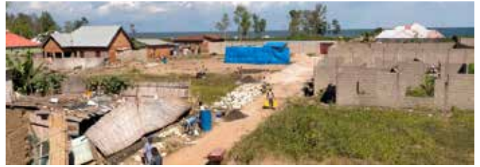
Il lotto del nuovo orfanotrofio
